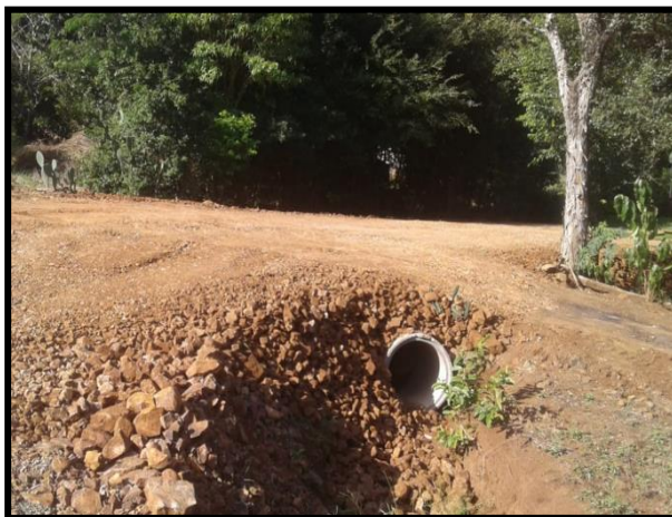
Foto 02 – Galeria de drenagem
