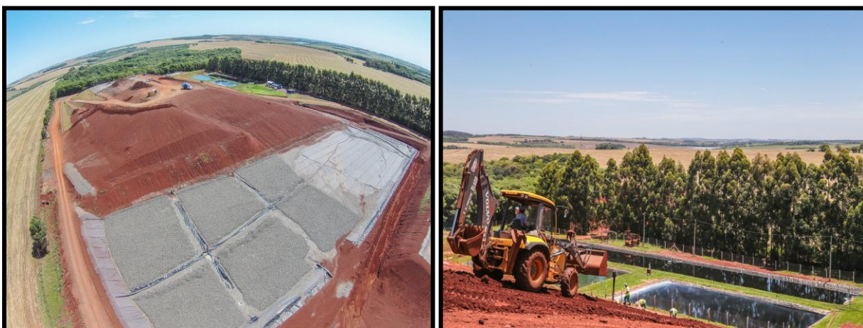
Figura 74: Células de Disposição Final.
