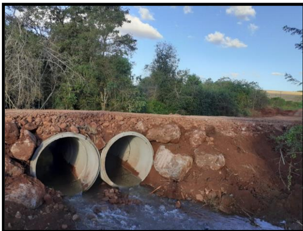
Foto 01 – Galerias de drenagem
