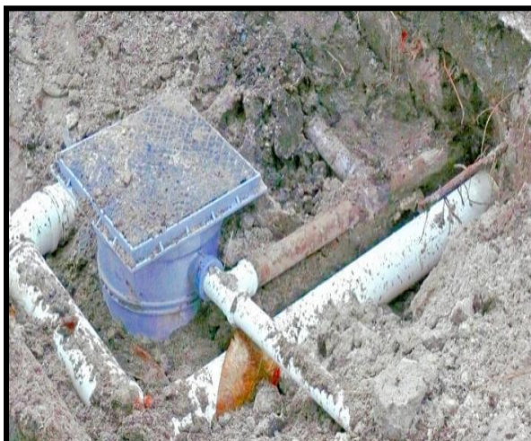
FOTO 03 – Caixa de gordura doméstica
